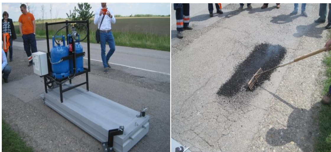
Машина са инфрацрвеним грејачима за репарацију асфалта и само крпљење ударне рупе
